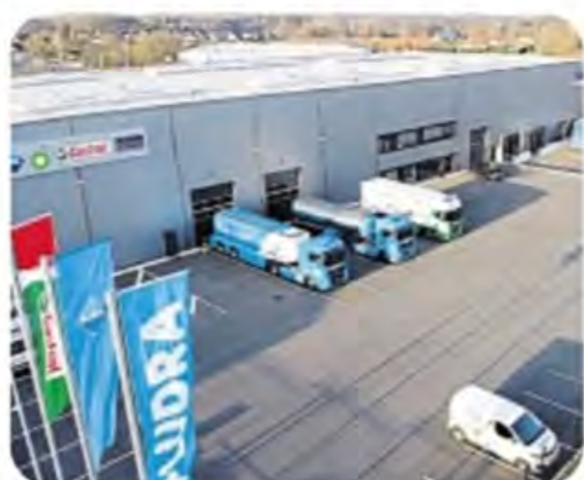
Mehr als drei Millionen Liter Schmierstoff lagern im neuen Logistikzentrum.
